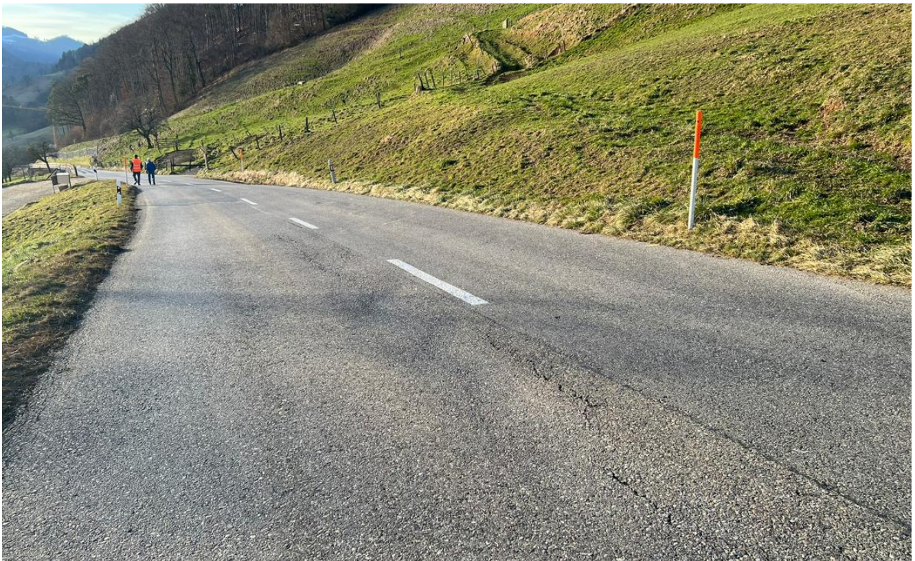
Abb. 6: Risse und Senkungen im Strassenbelag im Bereich um km 2.835, Aufnahmedatum 19.01.2026.
