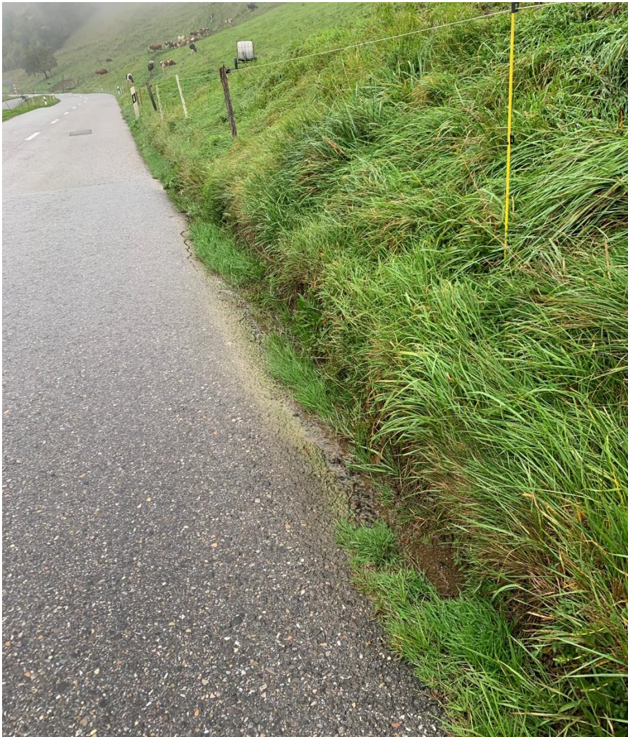
Abb. 7: Abgestochene bergseitige Böschung mit Wasseraustritt im Bereich um km 2.700, Aufnahmedatum 09.10.2025.
